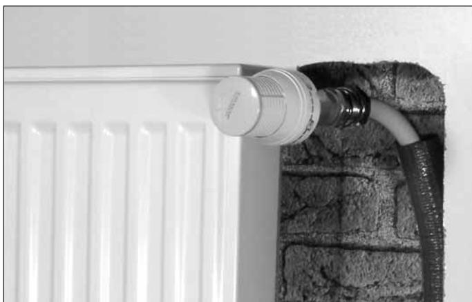
Podłączenie grzejnika z boku od ściany przy pomocy złącza alternatywnego
