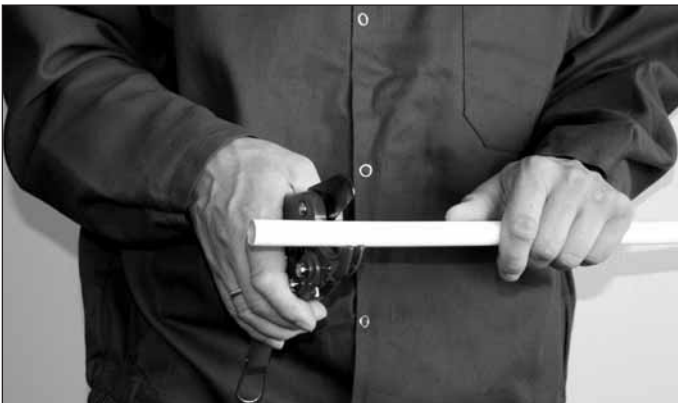
Przycięcie rury TECEflex® na żądany wymiar
