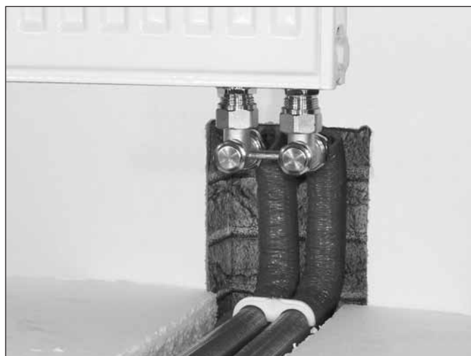
Zaizolowane podłączenie grzejnika
