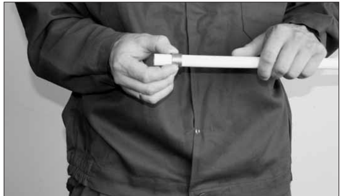
Nałożenie tulei zaciskowej na końcówkę rury
