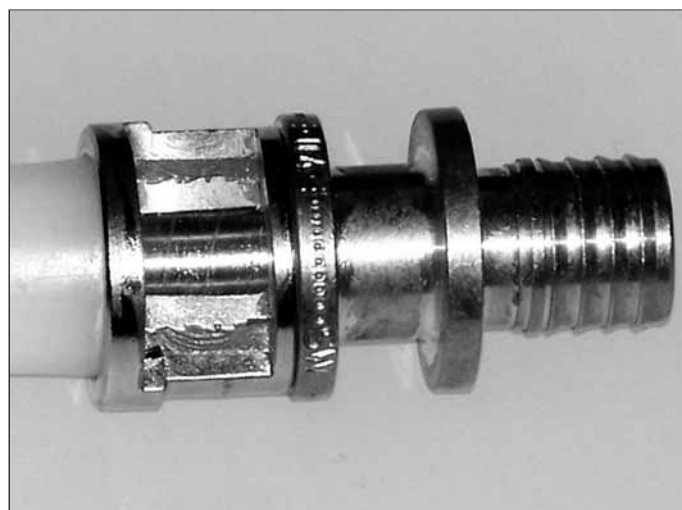
TECEflex® - złącze uszczelnione na całej powierzchni - typowe dla połączeń aksjalnych.
