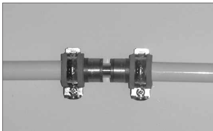
Wykonanie punktu stałego na dwuzłazce prostej
