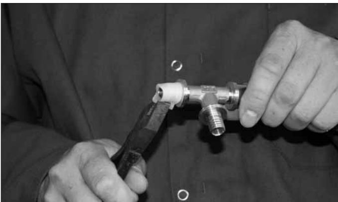
Oczyszczanie końcówki złączki po demontażu tulei
